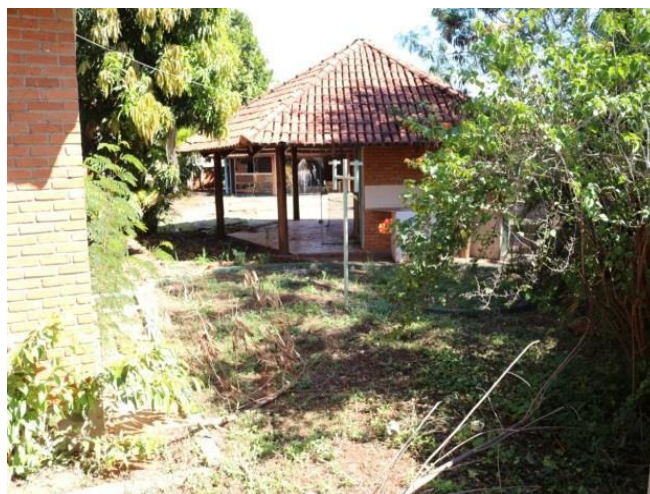
FIGURA 1: Brinquedoteca de Nerópolis (vista interna)
