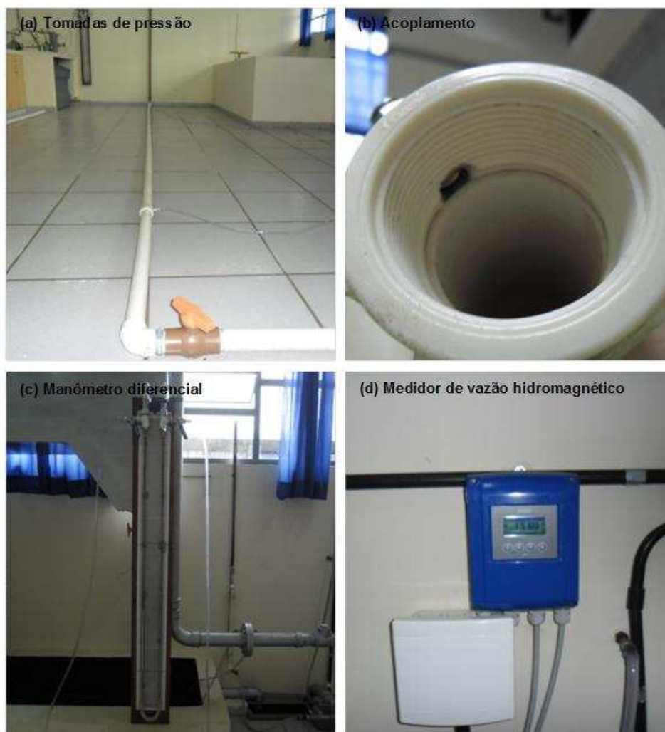
FIGURA 2. Tomadas de pressão alocadas (a), acoplamento das tomadas de pressão (b), manômetro diferencial (c) e medidor de vazão (d) empregados nos ensaios de perda de carga.
