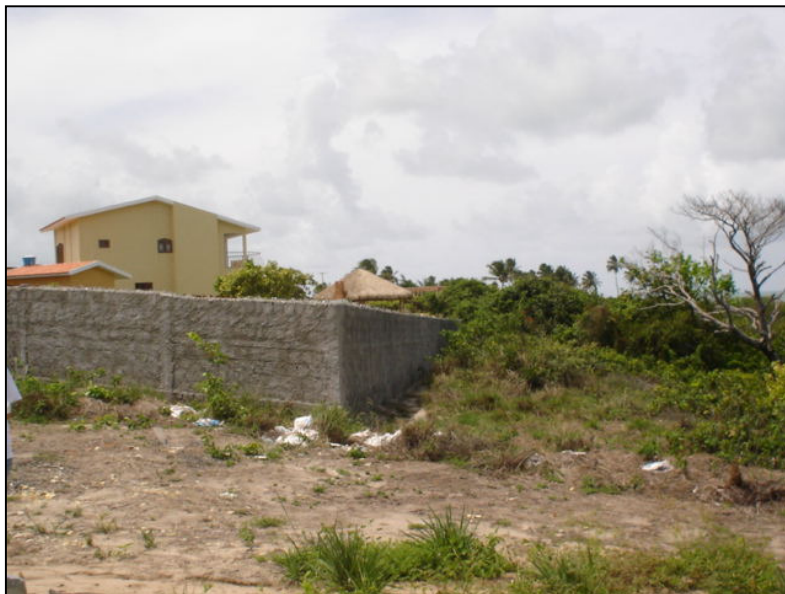
Figura 03 – Muro de residências avançando para Área de Preservação Permanente
