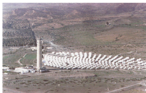
Figura 4.23. Campo de Heliostatos
